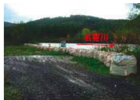
下川町三の橋地区 堰堤の右岸側から名寄川の水があふれて浸水した。無堤防地区なので堤防があれば浸水を防ぐことができた。ここはサンル川との合流点より上流側なので、サンルダムをつくったとしても、そもそもまったく効果のない場所である。
