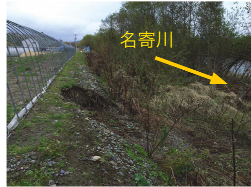
下川町上名寄地区 右岸堤防が未整備のため名寄川の水が氾濫した。川岸の盛土も浸食を受けている。サンルダムを建設しても、整備目標の洪水では浸水を免れられない。早急な対策が必要。
